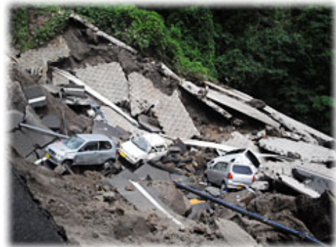
立ち往生した6台のうち4台が転落
