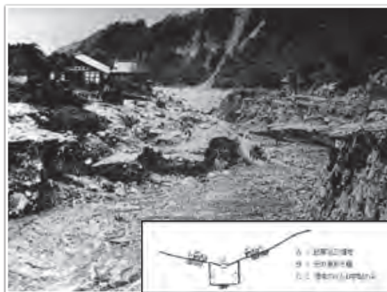
図1 土石流によって侵食された沼尾川（深山地区） 写真中央に数人の人が立っているから川の規模が分かる
