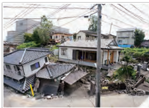
倒壊した建物（熊本県益城町）
