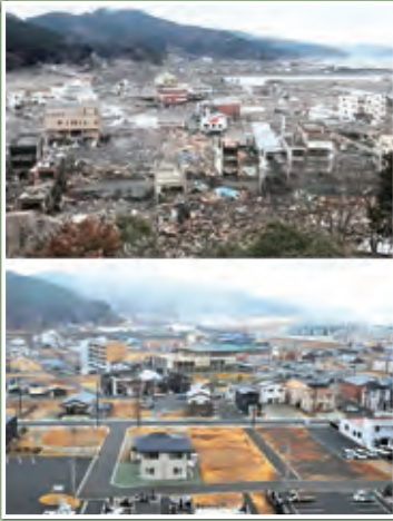
岩手県大槌町の被災状況（上）と15年後の現在
