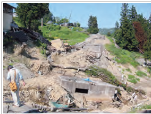
写真1 道路の盛土部分の崩壊（池谷集落） （2005年6月撮影）
