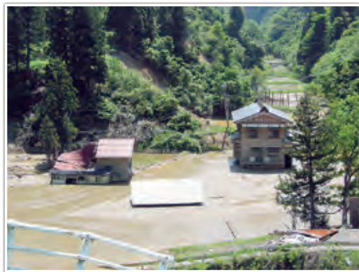
写真3 芋川の河道閉塞による木籠集落の湛水 （2005年6月撮影）
