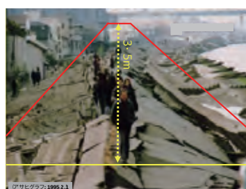
図3 新淀川の最大3.5メートル沈下した堤防上を徒歩通勤する人々
