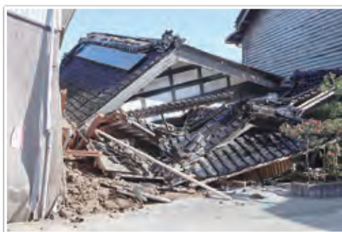
倒壊家屋（松波地区）
