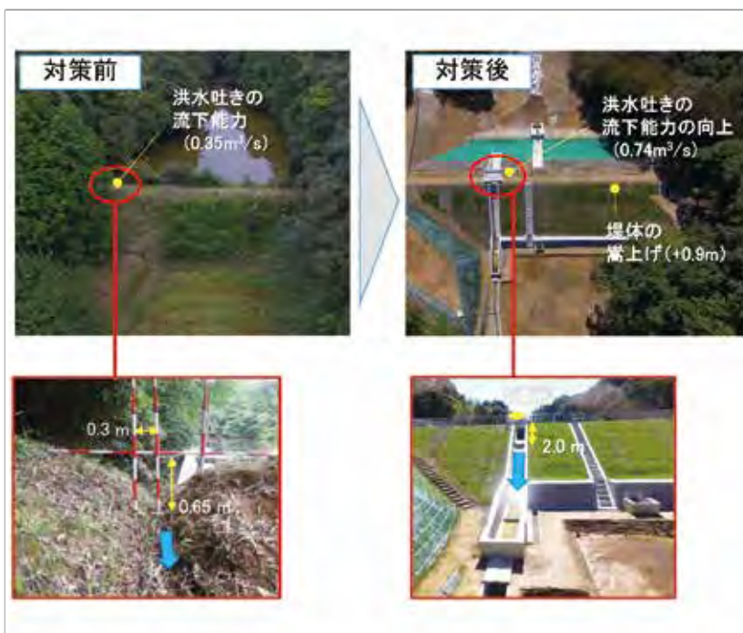
写真2 防災工事の状況
