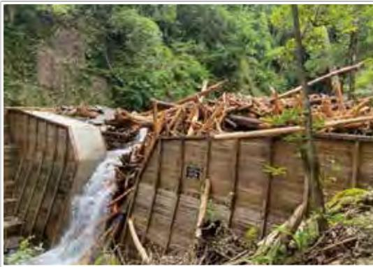
写真2 国土強靱化3か年緊急対策で整備した流木捕捉式治山ダムが令和2年7月豪雨で流木を捕捉（熊本県）
