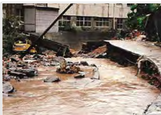
濁流で橋梁も電柱も車も流失した。 西彼杵郡長与町長与川水系高田川
