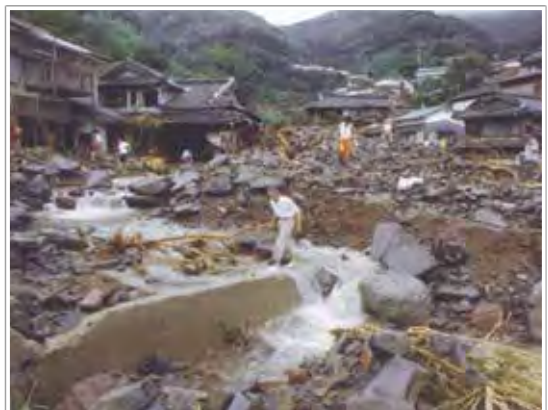
崖崩れが起こった国道34号線長崎市芒塚付近
