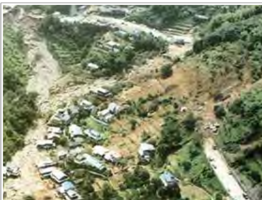
国道34号線長崎市矢上付近の被害現場
