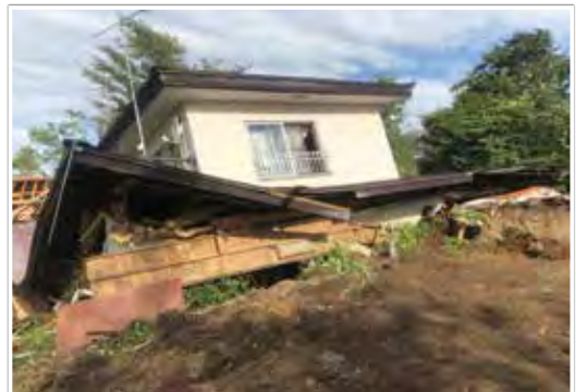
土砂により倒壊した家屋
