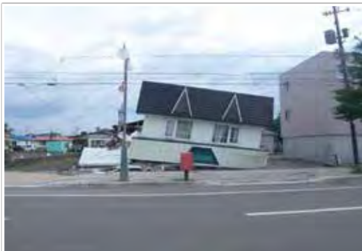
家屋倒壊の状況
