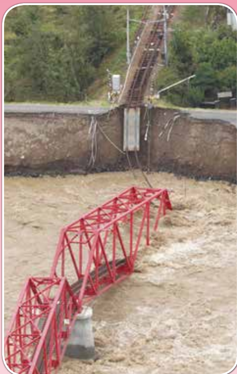
長野県上田市の千曲川にかかる上田電鉄別所線の鉄橋崩落
