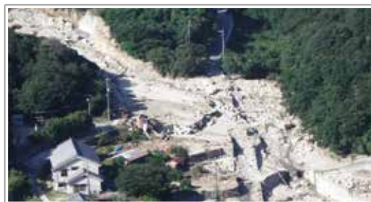
図2 土砂崩れによる被害(広島県呉市蒲刈地区)
