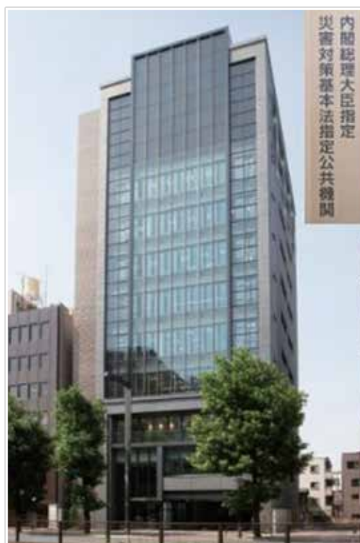
図1 全日本トラック総合会館（東京都新宿区四谷）
