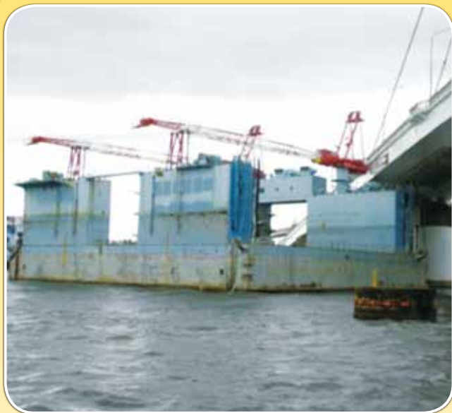
横浜市鶴見区の大黒大橋に接触した大型浮きドック
