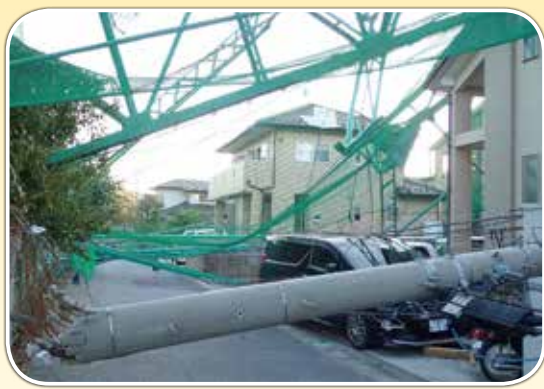
千葉県市原市でのゴルフ練習場の鉄塔倒壊
