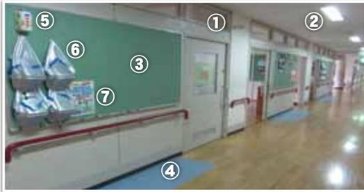
①ガラス飛散防止 ②蛍光管落下防止 ③掲示板固定補強
