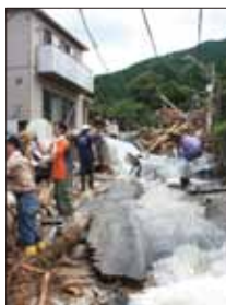
【表紙写真】 広島市土砂災害(平成26年8月20日) の現場活動状況
