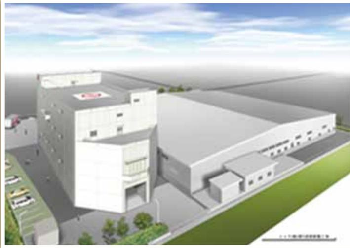
津波が押し寄せた際建物への圧力が軽減されるよう海に向けて舳型の形状としました。真上から見ると船のような形をしています。
